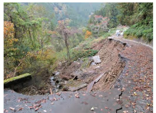
台風被災により崩落した林道
